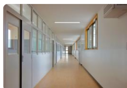
附属中学校校舎改修 (2020年度竣工)
